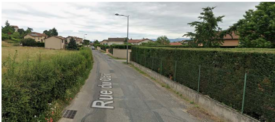
Chaussée sur l'intégralité de la voie entre une haie champêtre et les parcelles pavillonnaires
