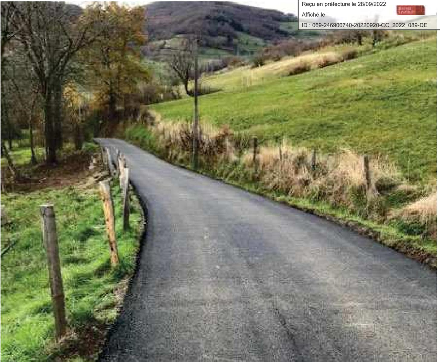
La voie présentait de nombreux désordres : affaissement, arrachement de revêtement, nids de poule... Les travaux ont permis de renforcer les parties les plus dégradées avec des soutènements en roches.
