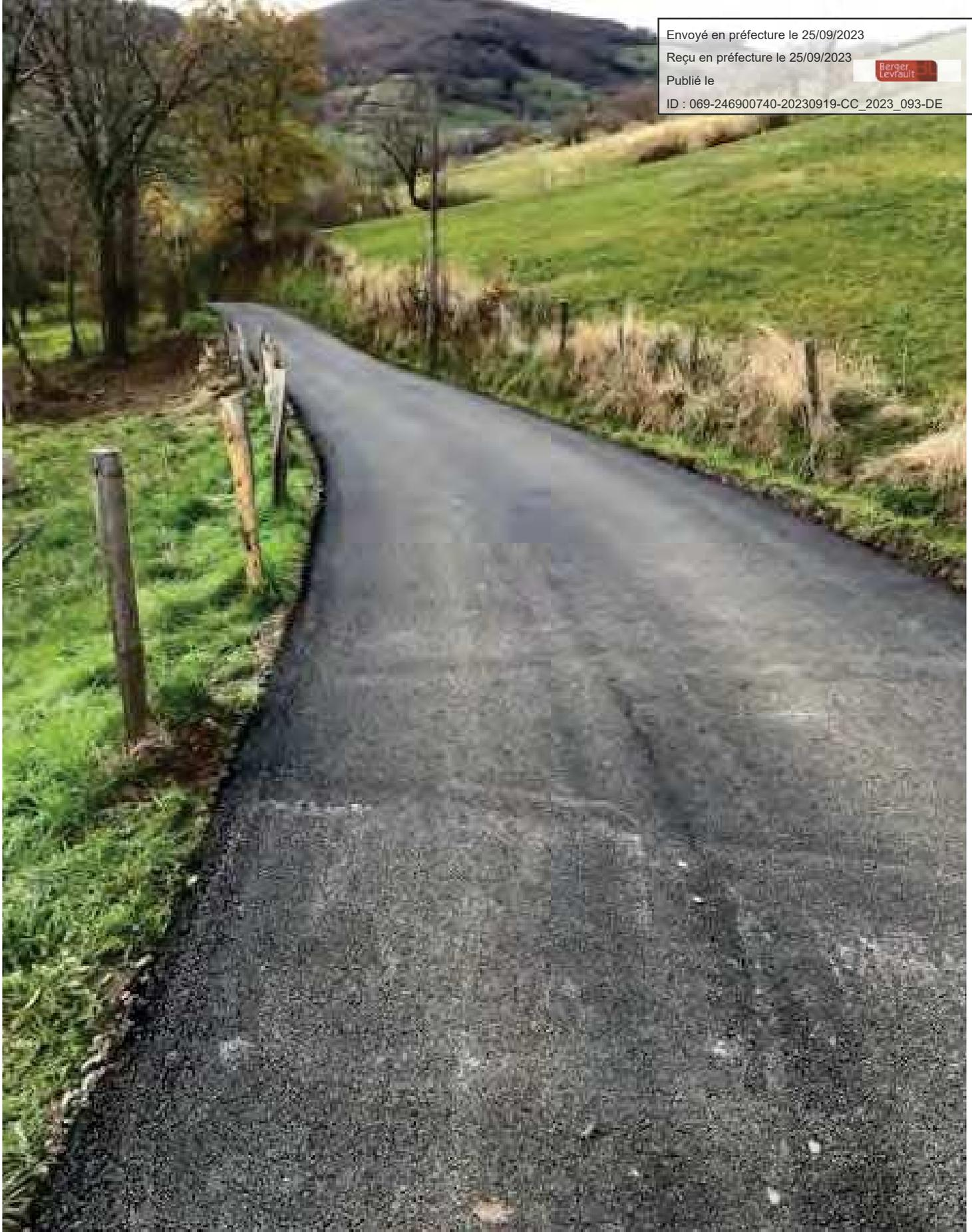
La voie présentait de nombreux désordres : affaissement, arrachement de revêtement, nids de poule... Les travaux ont permis de renforcer les parties les plus dégradées avec des soutènements en roches.
