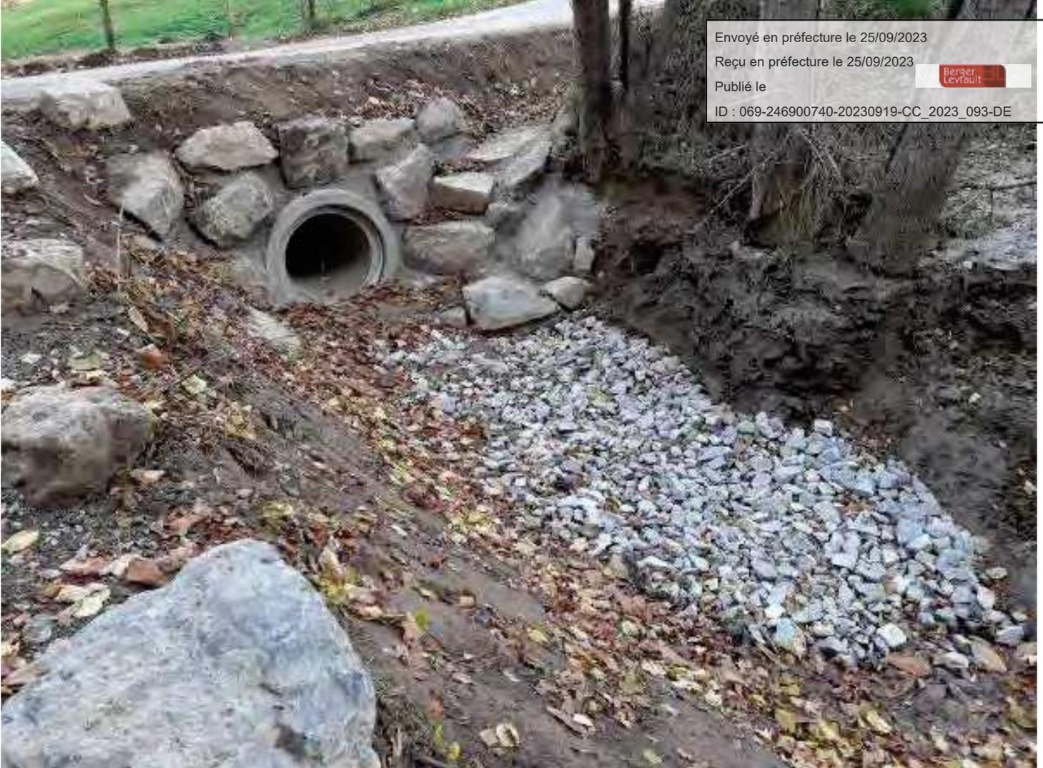
Intervention d'urgence pour remédier à l'obstruction d'un ruisseau transitant sous la route. Pose d'une canalisation en lien avec le SMAGGA et reprise de l'enrobé.
