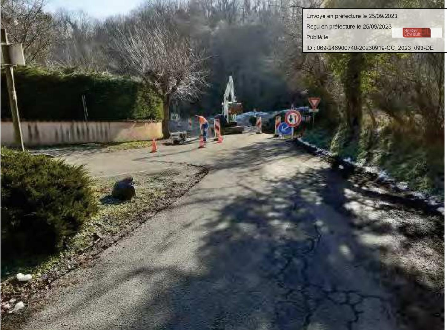
Le carrefour initial était peu lisible pour les usagers en raison de la difficulté à trouver sa place sur la chaussée dans un espace (trop) large et mal défini. Les travaux réalisés ont consisté à améliorer la visibilité des carrefours, clarifier les fonctionnalités et réduire la vitesse des automobilistes.
