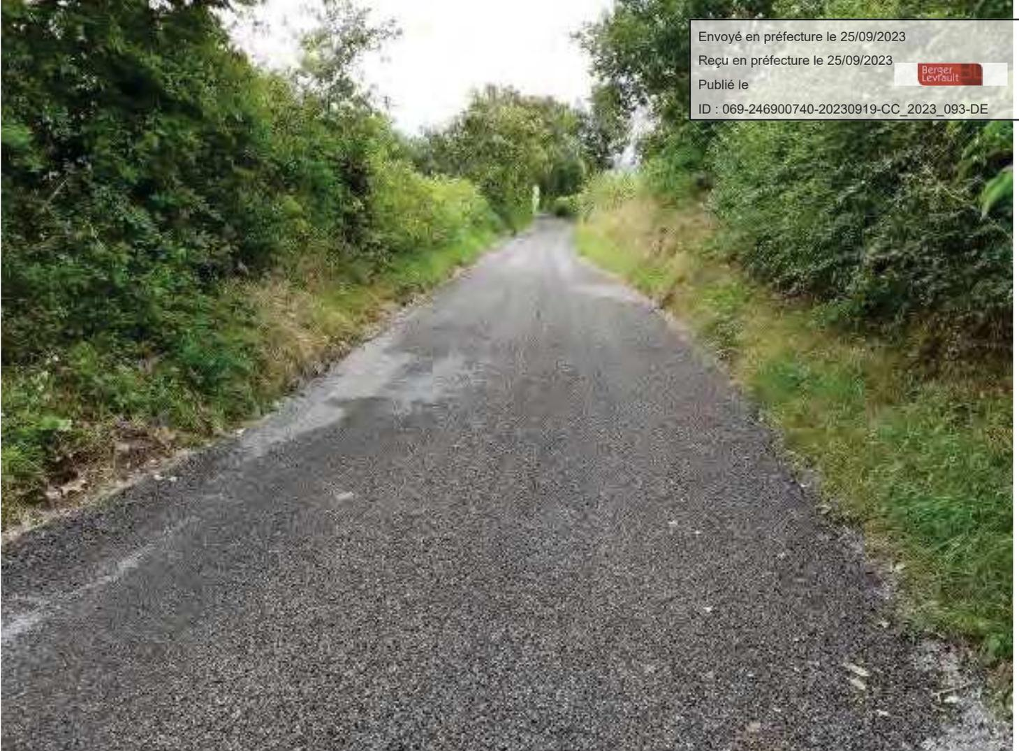
Exit le chemin caillouteux et le ruissellement des eaux de pluie. Sur plusieurs centaines de mètres, le chemin des Côtes est désormais recouvert d'enduit gravillonné à l'émulsion de bitume.
