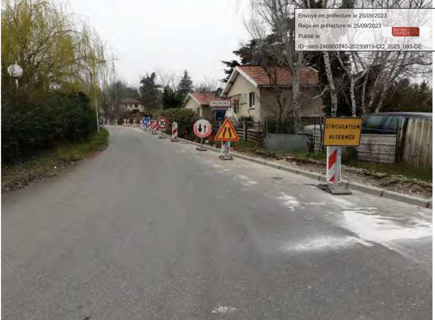
Réfection de la chaussée de la route des Fontaines à Taluyers sur la totalité de la voie entre la RD342 et la rue du Prieuré, soit environ 850 mètres de long. Ces travaux relèvent du plan de sauvegarde du Schéma directeur.
