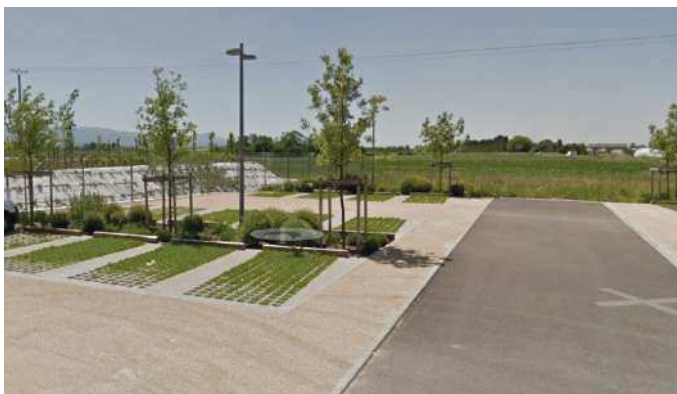
Figure 3 Exemple -Parking dalle béton alvéolé
