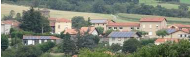
Des toitures photovoltaïques de la Centrale Villageoise de la Région de Condrieu (commune des Haies)
