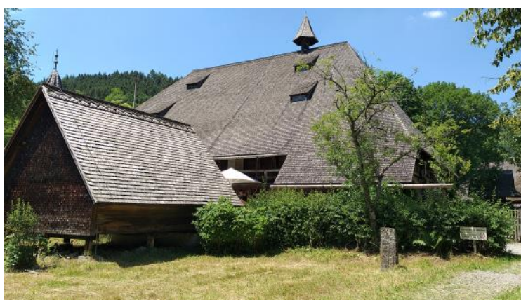
Ferme de 1599 avec son grenier séparé – précaution en cas d'incendie – et son clocheton pour signaler un événement important (décès...) aux fermes des alentours Bauernhof aus dem Jahr 1599 mit einem separaten Speicher - Vorsichtsmaßnahme im Falle eines Feuers - und einem Türmchen, um den Bauernhöfen in der Umgebung ein wichtiges Ereignis (Todesfall...) zu melden
