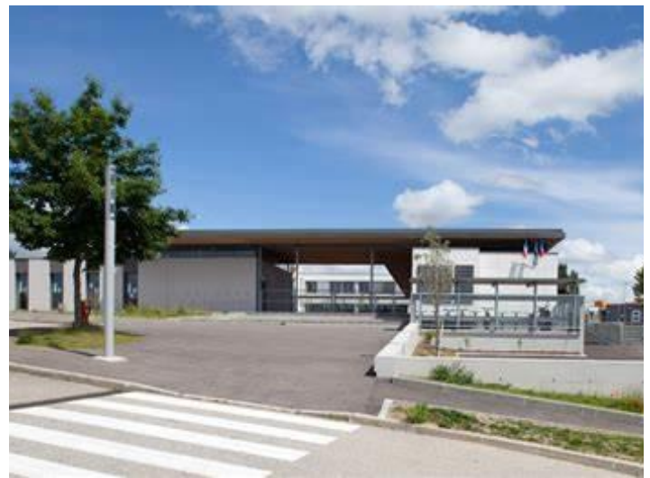
Entrée du collège La Perrière à Soucieu-en-Jarrest
