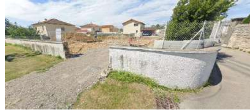
Après (Beauvallon, rue du Breuil)
